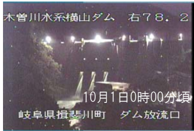
横山ダム放流状況
