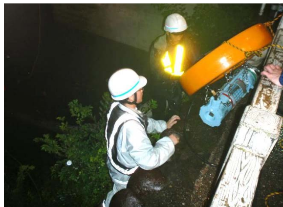
排水ポンプ車設置・稼働状況 (7月8日)
