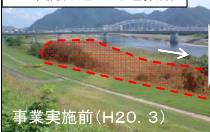
忠節橋付近の河道掘削
