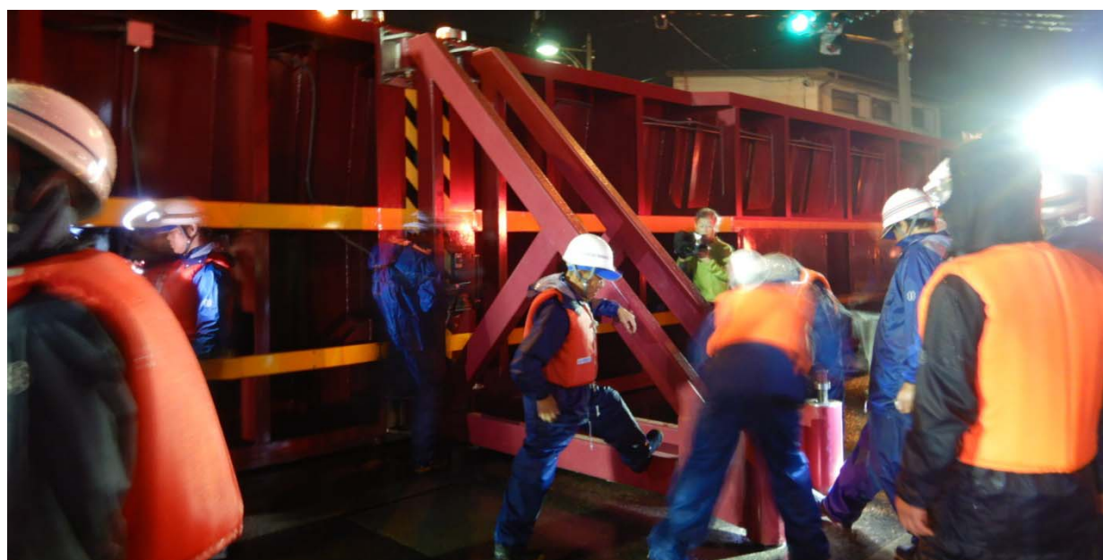
大宮陸閘（岐阜市・長良川左岸）の閉鎖状況 （7月8日0時30分頃）
