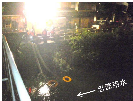
排水ポンプ車設置・稼働状況 (7月8日)
