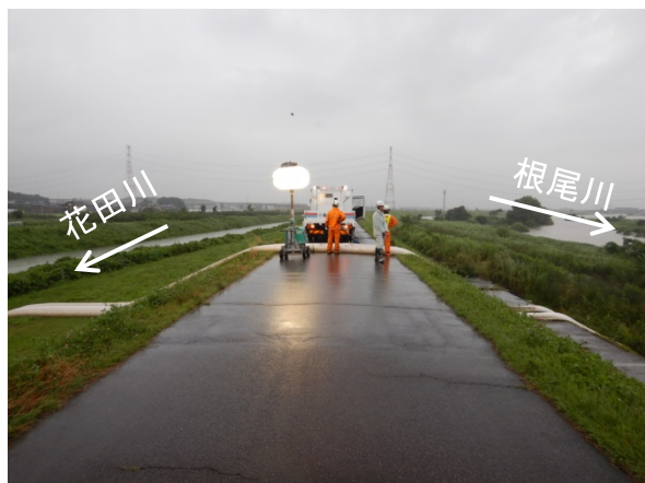
排水ポンプ車稼働状況（7月5日）
