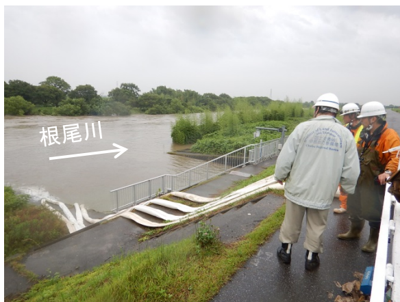
排水ポンプ車稼働状況（7月5日）
