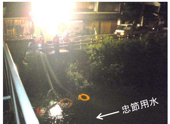
排水ポンプ車設置・稼働状況 (7月8日)
