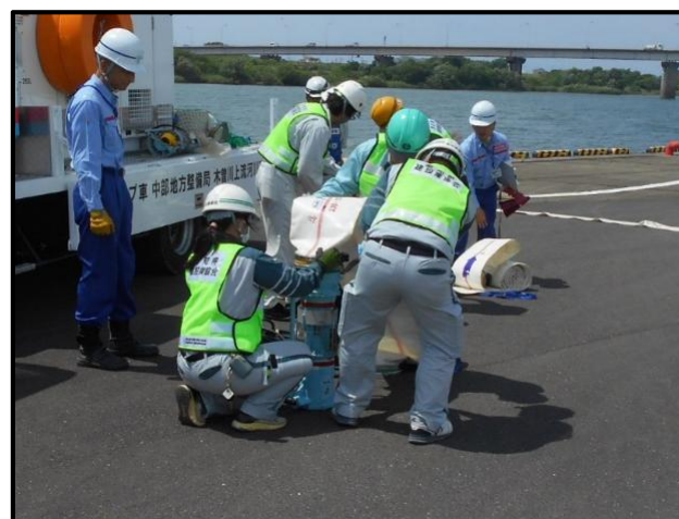
■ 排水ポンプの組み立て
