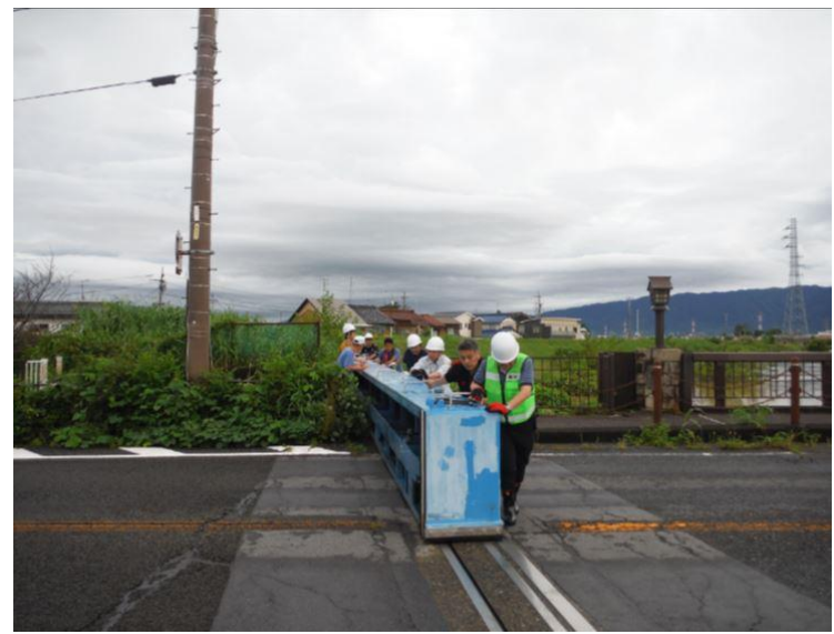
塩田橋陸閘の閉鎖状況
