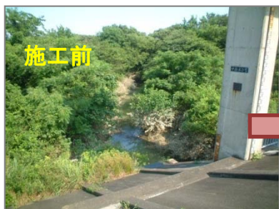
河道内樹木の伐開
