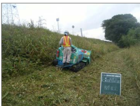
堤防法面管理(除草)
