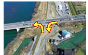
① 名神高速道路と揖斐川左岸堤防との接続 (平成28年3月完成) 長良川左岸・輪之内町
