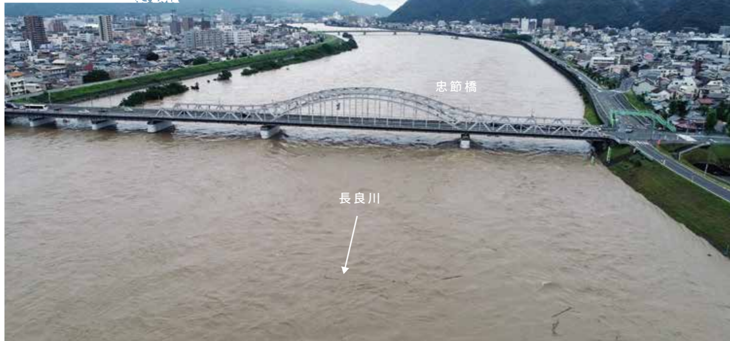
岐阜市忠節橋の出水状況
