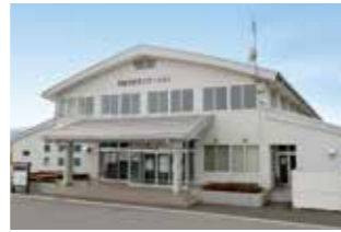
木曾川羽島河川防災ステーション
