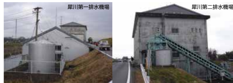
↑H24年3月 犀川第一排水機場、犀川第二排水機場 撤去完了
