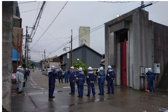
陸閘閉鎖開始指示(長良南町陸閘)
