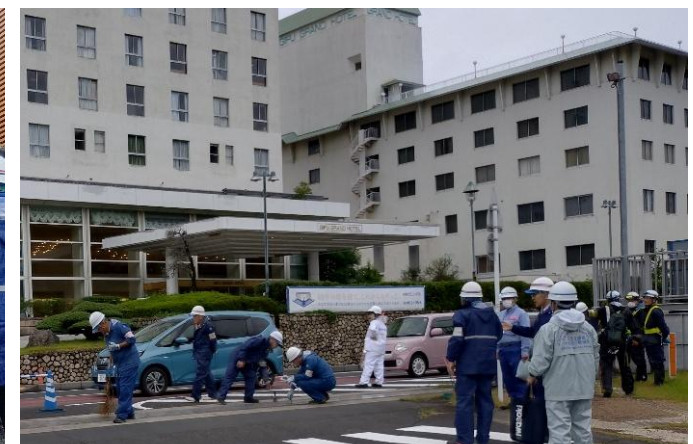
陸閘閉鎖前準備(築地陸閘)
