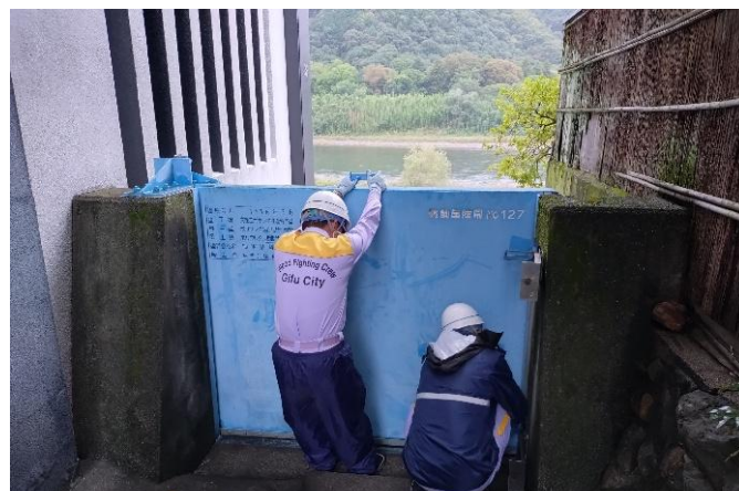
陸閘閉鎖状況(鵜飼屋陸閘No.127)
