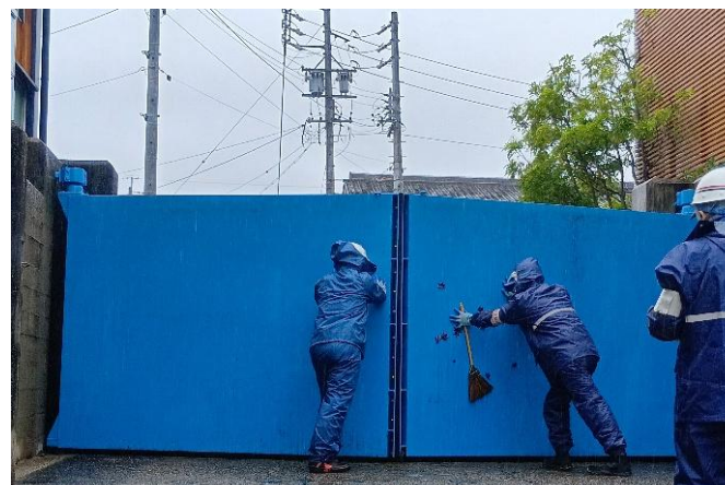
陸閘閉鎖状況(鵜飼屋陸閘No.110)
