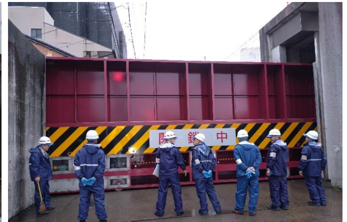
陸閘閉鎖状況(長良南町陸閘)
