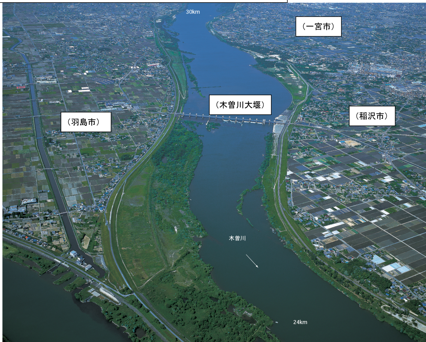
木曽川大堰周辺状況写真(木曽川24k-30k付近)
