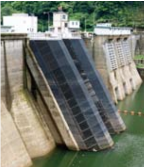
⑤選択取水設備 ダム湖の水は、水深で水温や水の濁りが異なります。取入口が上下する選択取水設備であれば、適切な水深から水を取り入れ、下流に流すことができます。
