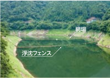
③網場(あば) ダム湖内に入り込んできた流木やゴミなどをせき止め、ゲートなどのダム施設を守ります。
