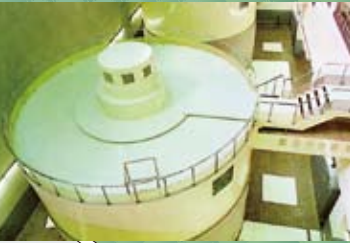
横山発電所(中部電力) ダム湖に貯めた水を利用して最大70,000kWの発電を行います。
