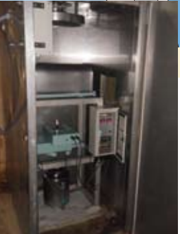
プラムライン ダムの変形、変位をプラムライン(懸垂線)を応用して測定する装置です。
