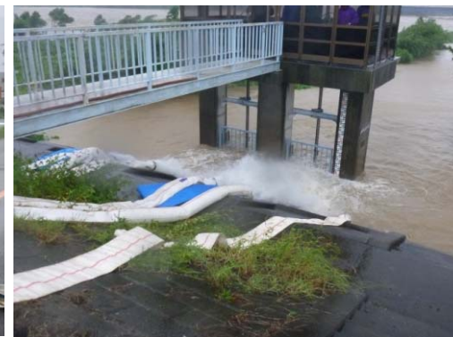
9月16日7時頃 排水ポンプ車の設置の様子
