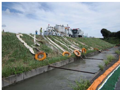
9月16日 11時頃 排水ポンプ車の設置状況
