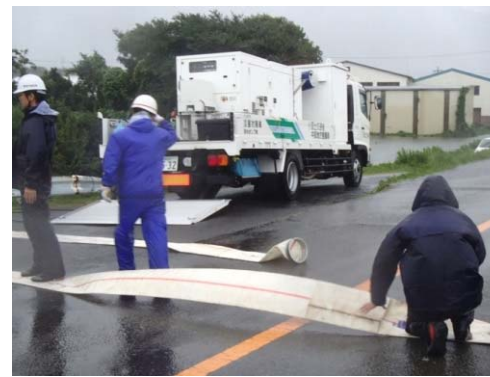
9月16日8時頃 排水ポンプ車による排水状況
