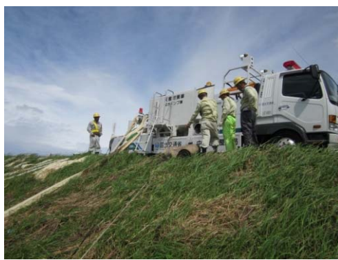
9月16日 11時頃 排水ポンプ車の設置状況
