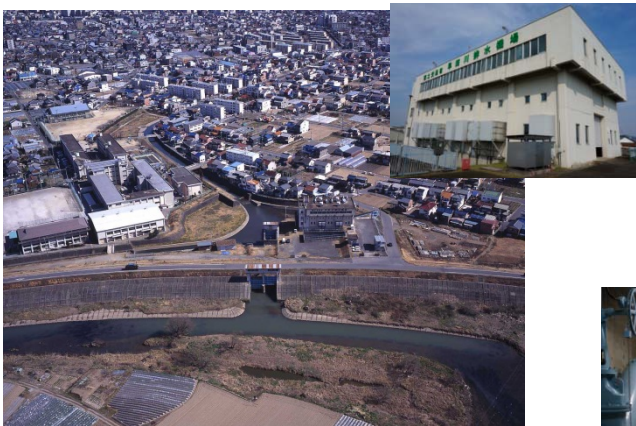
【排水機場全景】
