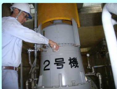
ポンプの点検
