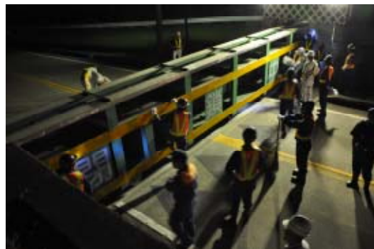
陸閘点検実施状況
