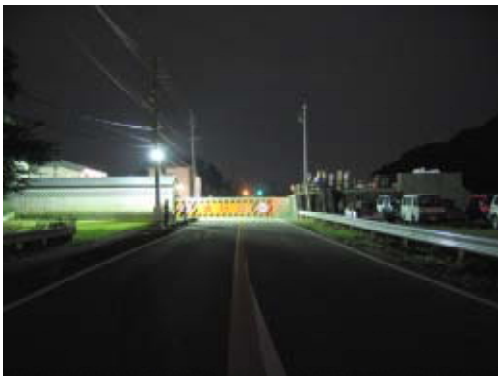
陸閘全景 (鵜沼側より勝山陸閘を望む)
