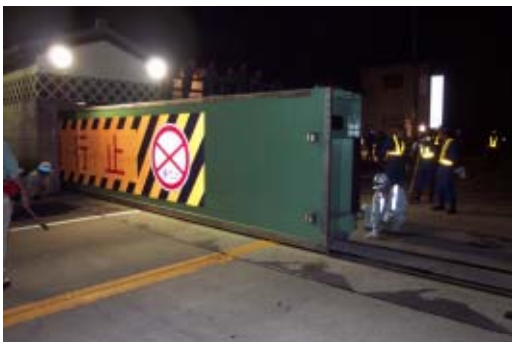
陸閘閉鎖作業状況
