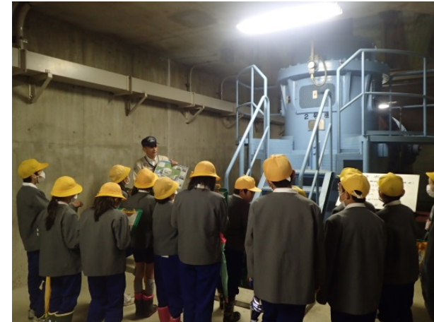
ポンプ室の見学
