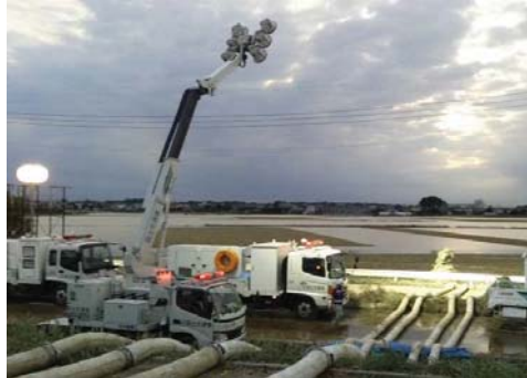
排水ポンプ車による排水作業
