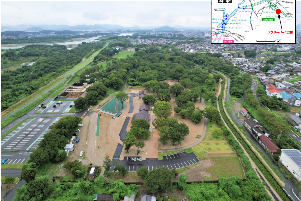
Ⅱ期地区(約 9.5ha)全景
