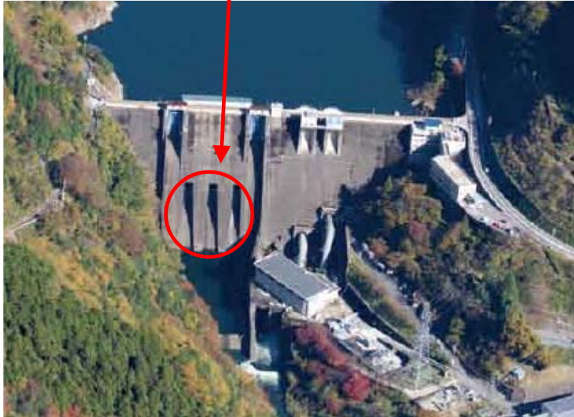
横山ダム 常用ゲート（オリフィスゲート）
