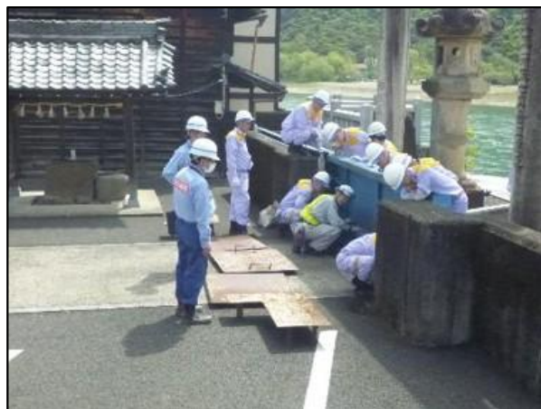
陸閘閉鎖状況（鵜飼屋陸閘）
