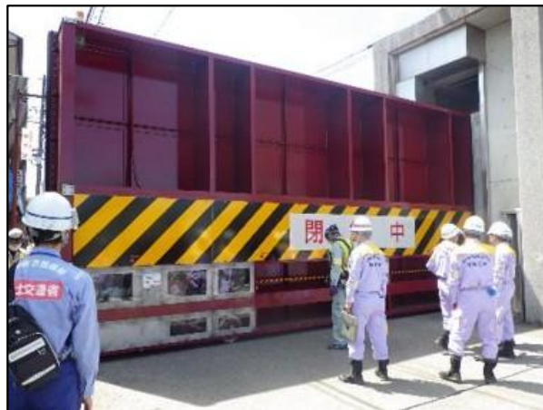
陸閘閉鎖状況（長良南町陸閘）
