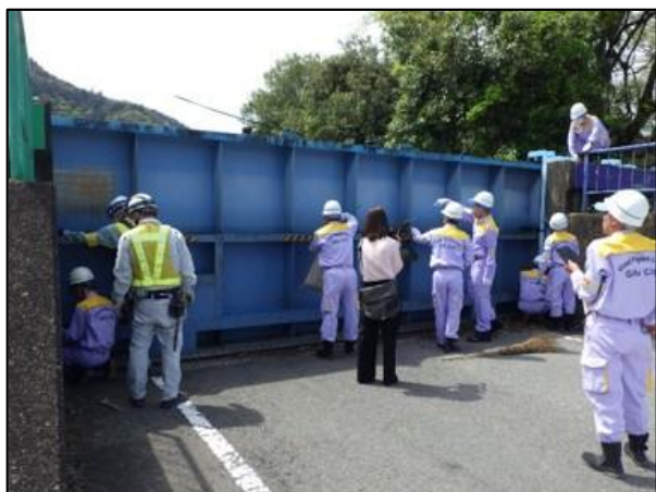
陸閘閉鎖状況（大前町陸閘）
