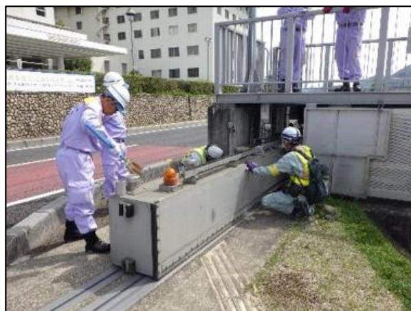
陸閘設備点検状況（築地陸閘）
