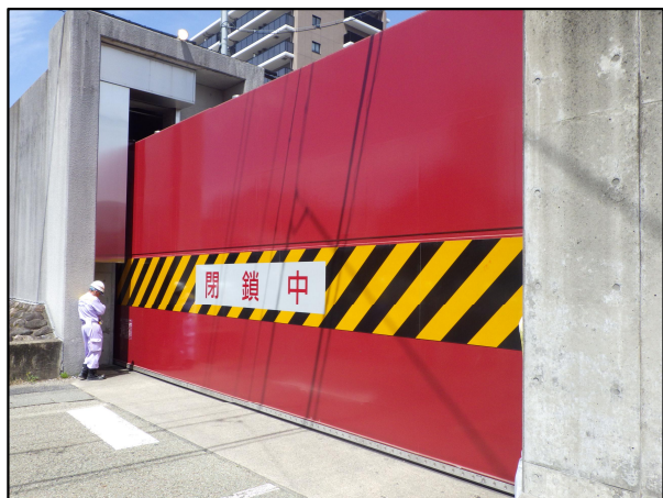
陸閘閉鎖状況（長良南町陸閘）
