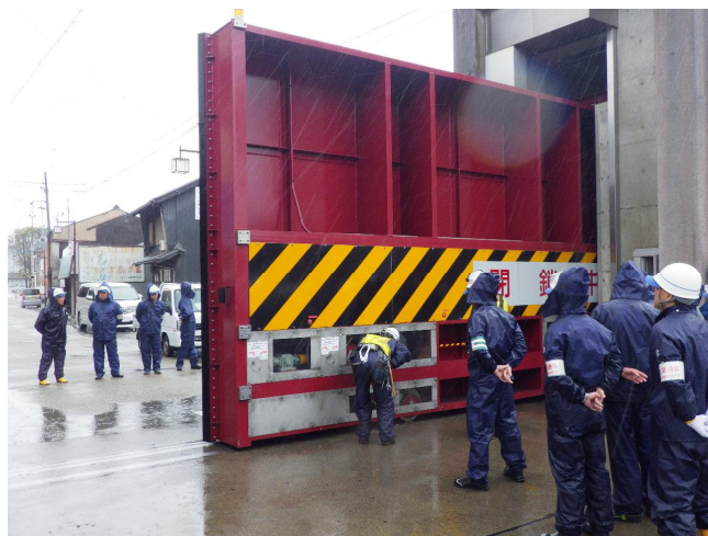
長良南町陸閘の閉鎖訓練
