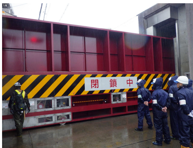
長良南町陸閘の閉鎖及び点検状況
