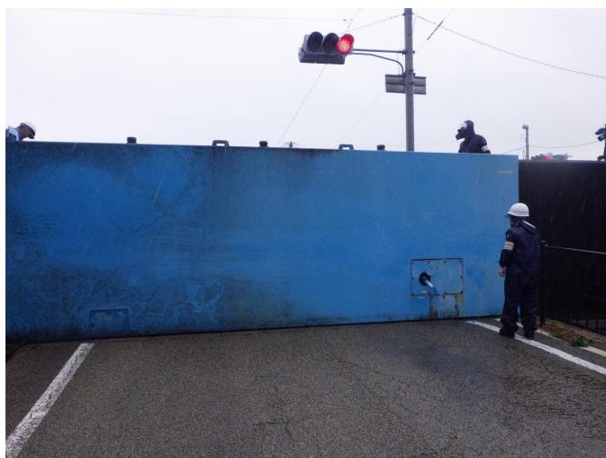
大前町陸閘の閉鎖訓練及び点検
