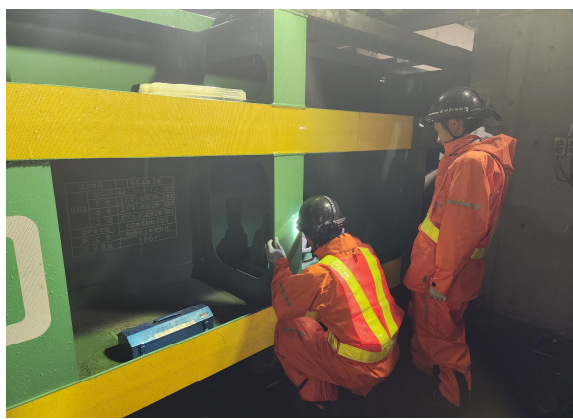
陸閘点検実施状況
