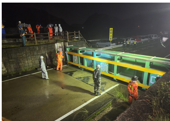
陸閘閉鎖作業状況
