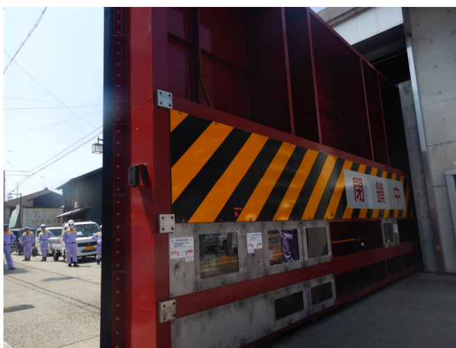
長良南町陸閘の閉鎖訓練
