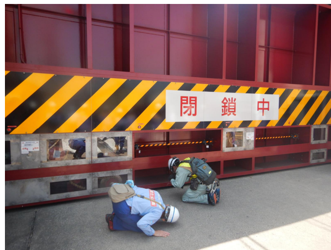
長良南町陸閘の閉鎖及び点検状況
