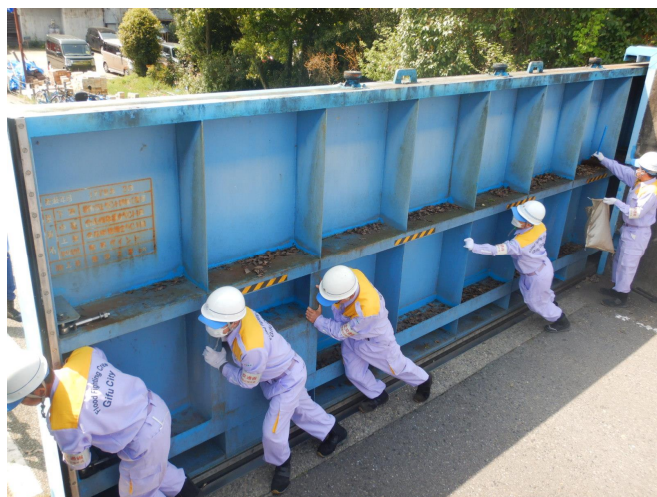
大前町陸閘の閉鎖訓練及び点検
