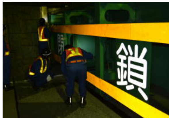
陸閘点検実施状況
