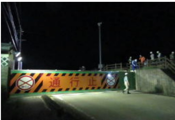
陸閘全景 通行止め実施状況 (鵜沼側より勝山陸閘を望む)
