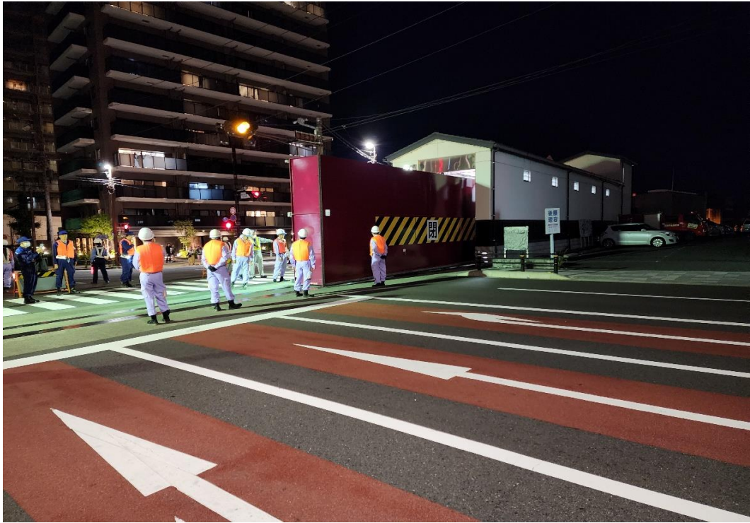
長良陸閘（閉鎖中）
