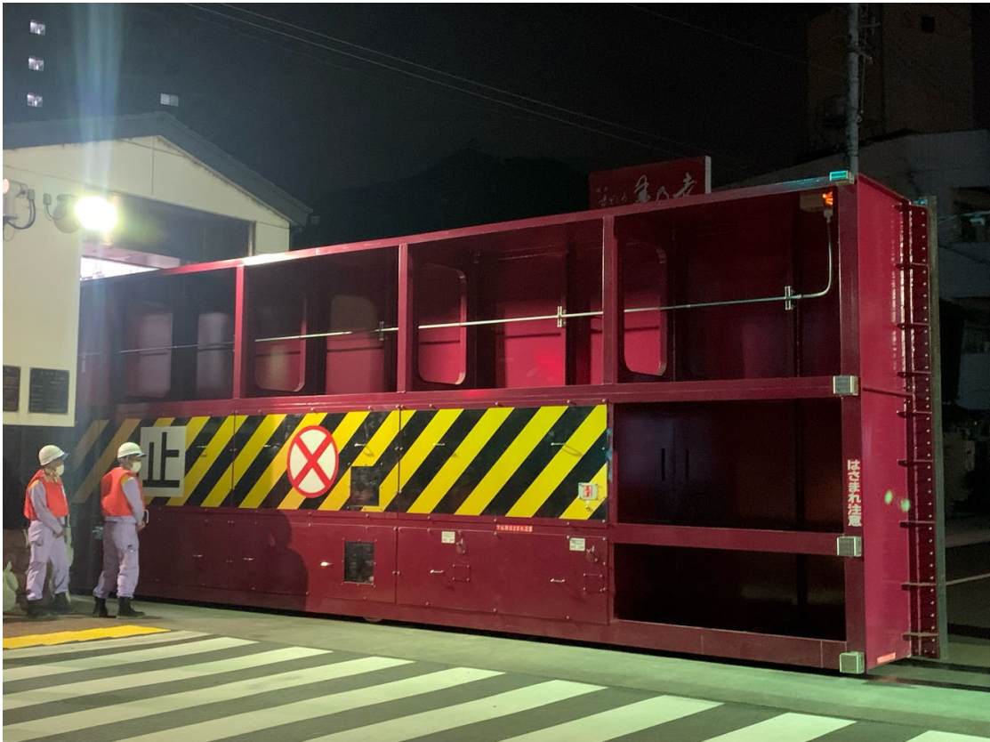
長良陸閘（閉鎖中）
