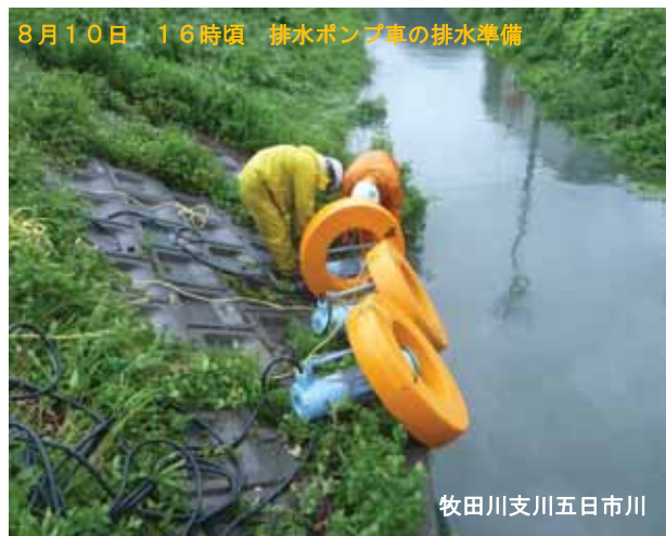
8月10日 16時頃 排水ポンプ車設置状況
