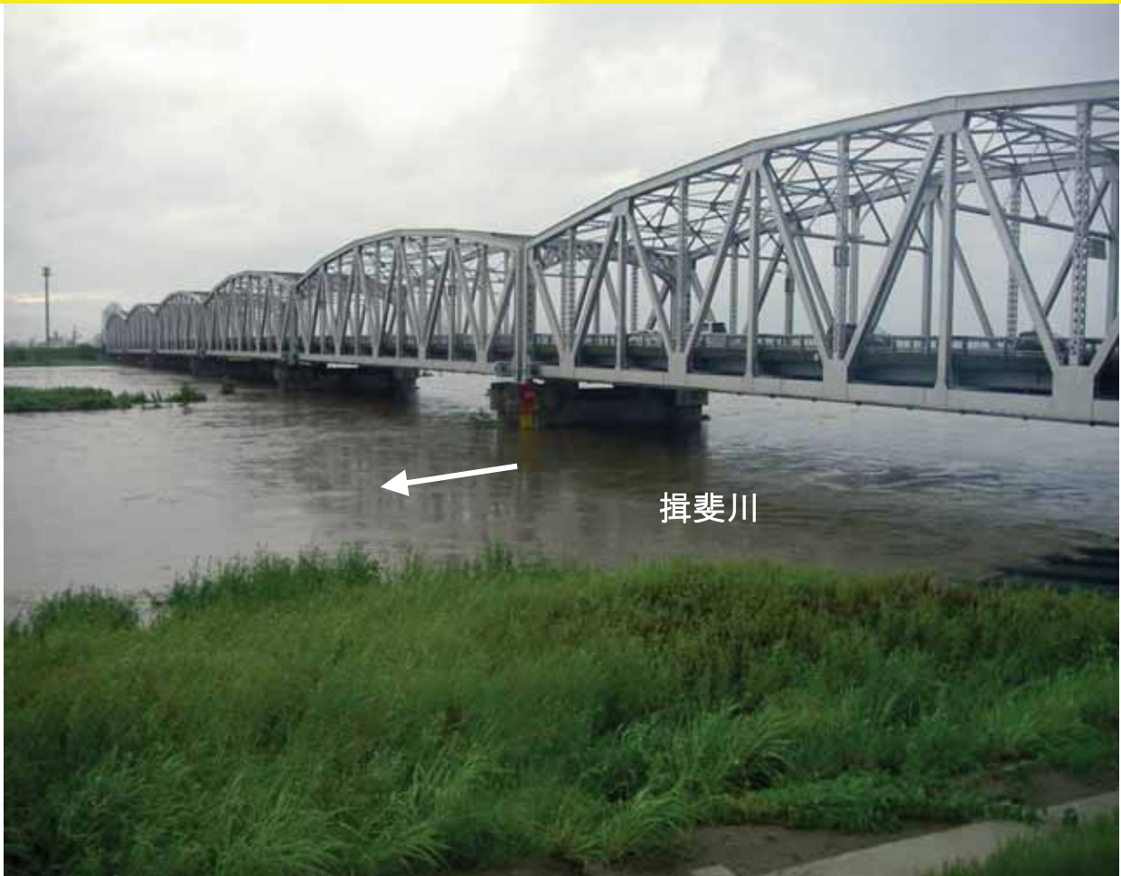
揖斐川の出水状況（8月10日19時頃）揖斐大橋付近（岐阜県大垣市）
