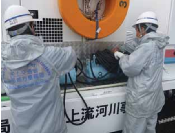
8月10日 16時頃 排水ポンプ車の排水準備
