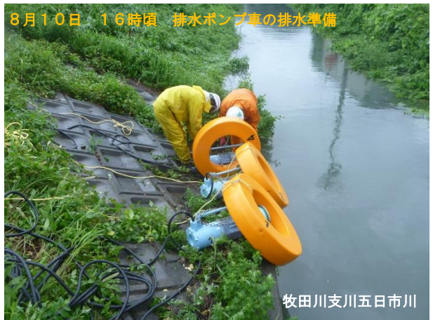
8月10日 16時頃 排水ポンプ車設置状況
