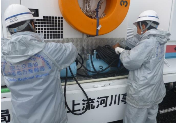
8月10日 16時頃 排水ポンプ車の排水準備
