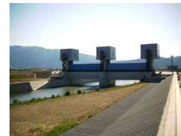
泥川水門 (平成23年完成) 岐阜県
