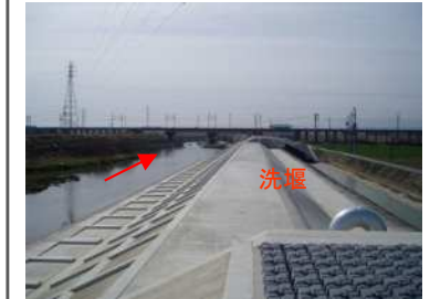
大谷川洗堰嵩上げ (1.05m) (平成19年完成) 岐阜県
