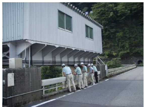
堤体及び周辺の点検状況
