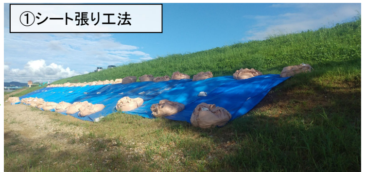
応急復旧完了 (8月18日17時頃)
