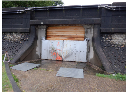
起陸閘の閉鎖状況
