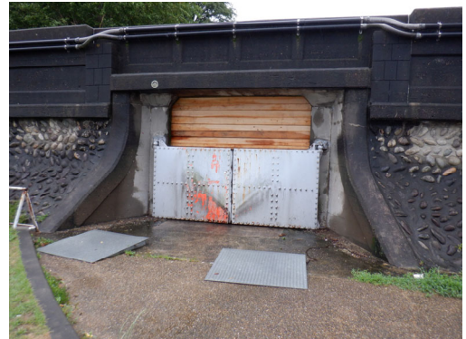
起陸閘の閉鎖状況
