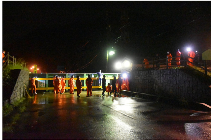
勝山陸閘の閉鎖状況
