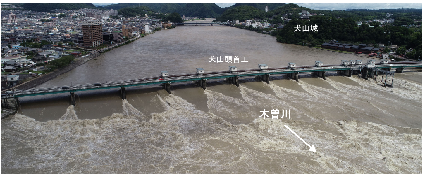
木曾川の出水状況（8月15日正午頃）56.4k付近
