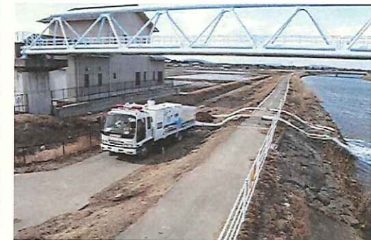
東松島市矢本の排水作業
