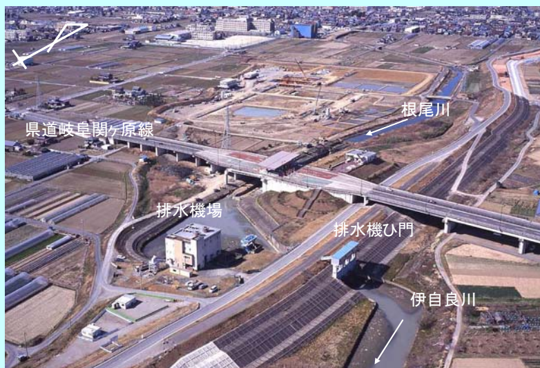
根尾川排水機場（伊自良川）
