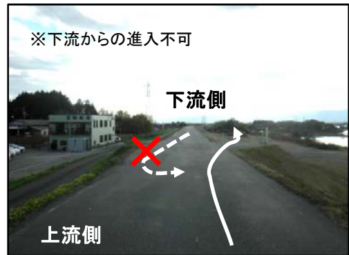
②堤防からの入口
