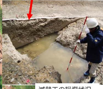
減勢工の損傷状況（横山ダム）
