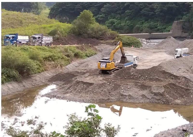
土砂掘削（横山ダム）
