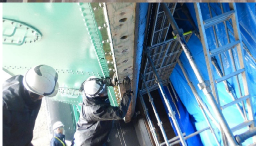
洪水吐水密ゴム交換（丸山ダム）
