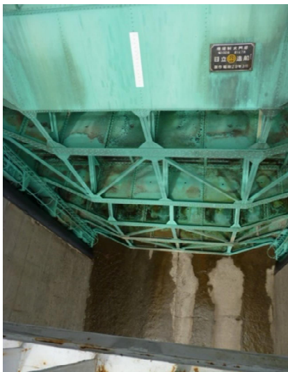
洪水吐水密ゴム交換（丸山ダム）
