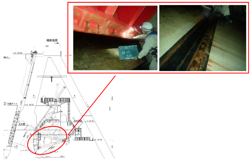
主放流設備修繕（横山ダム）
