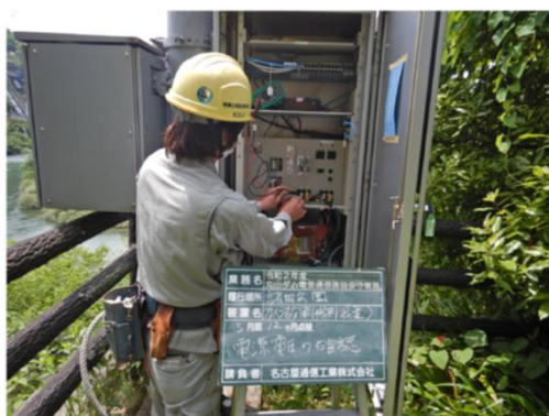
電気通信施設の点検
