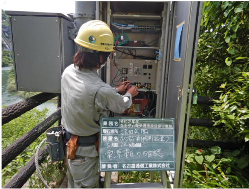
電気通信施設の点検
