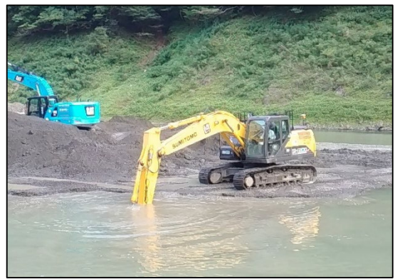
ダム貯水池掘削（横山ダム）
