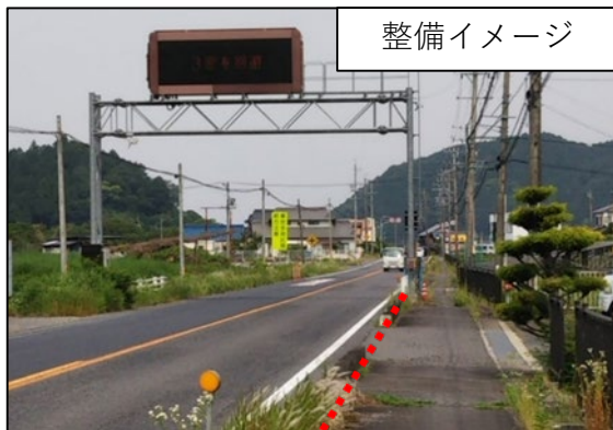
光ケーブル敷設工事（丸山ダム）
