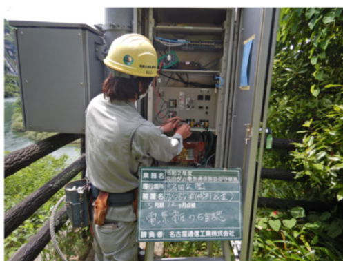
電気通信施設の点検
