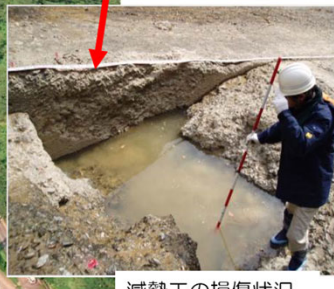
減勢工の損傷状況（横山ダム）
