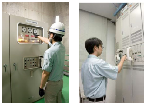
機械設備、電気設備等の点検
