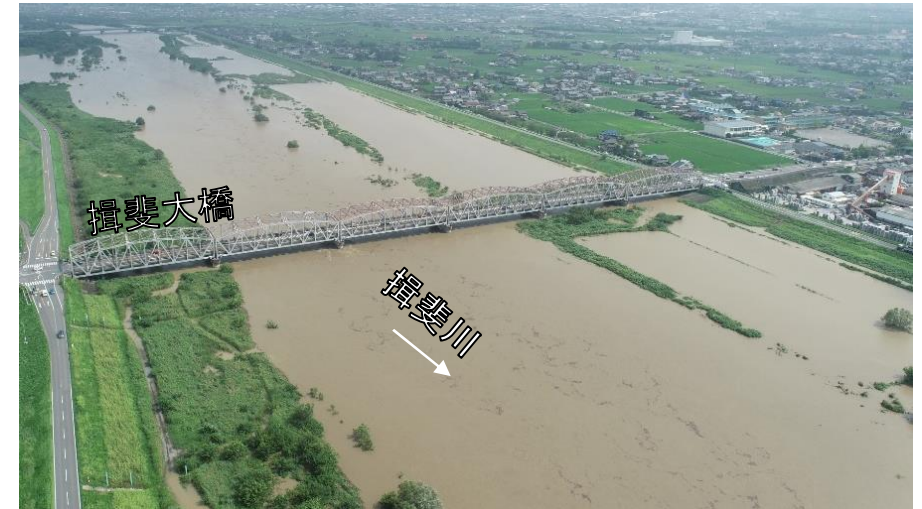
揖斐川の出水状況(8月16日10時頃)40.6k付近 3
