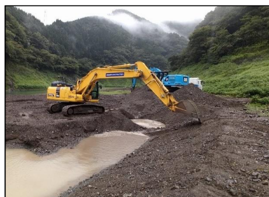
ダム貯水池掘削（横山ダム）
