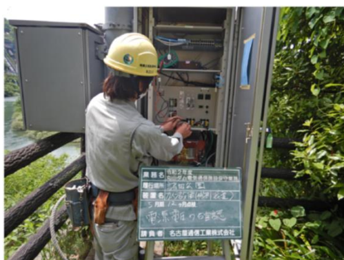
電気通信施設の点検
