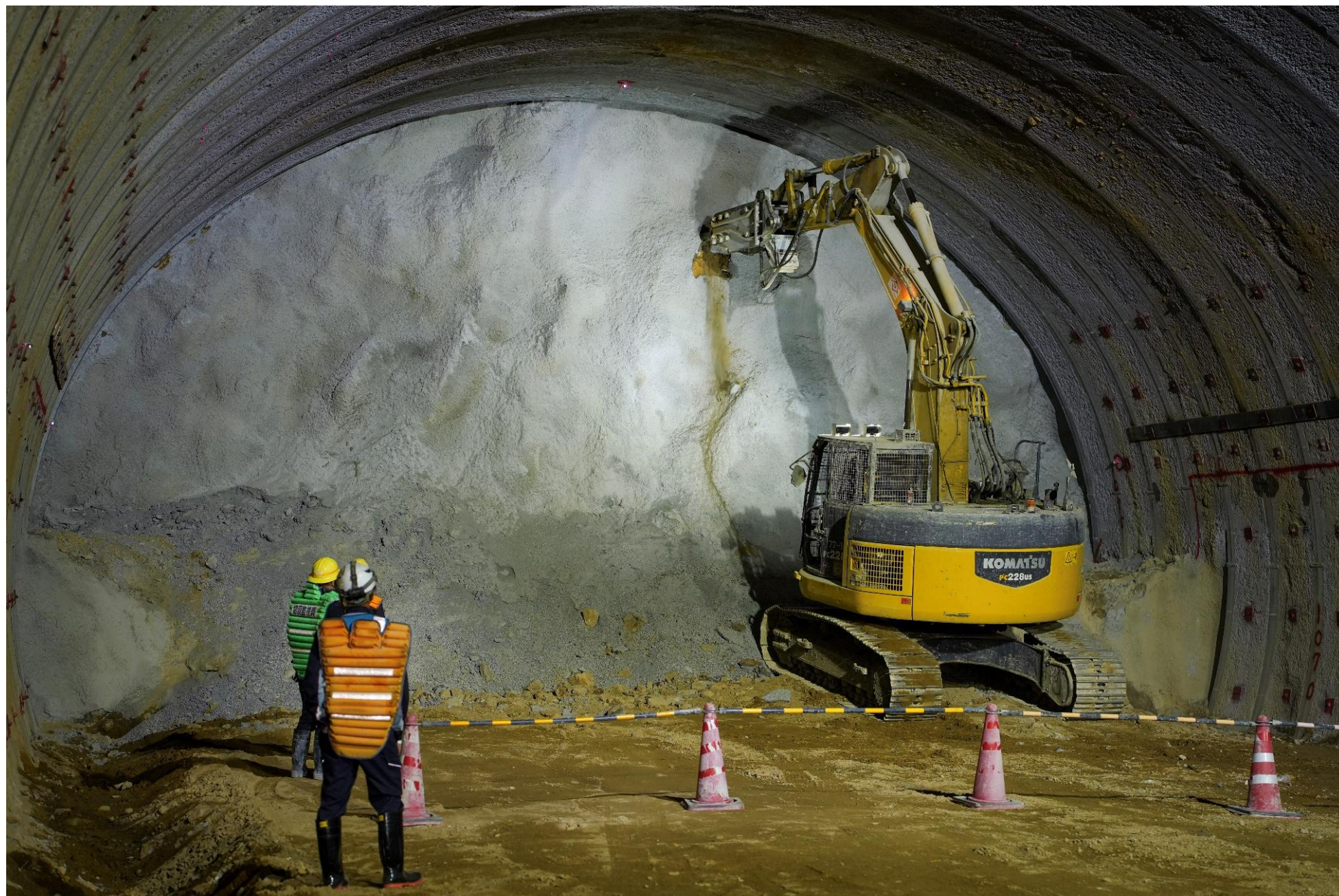
トンネル貫通前の様子
