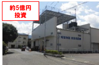
急速冷凍保管庫を建設 (尾鷲物産(株))
