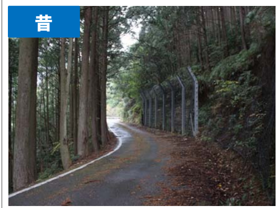
道幅が狭く、車のすれ違いも困難な峠道
