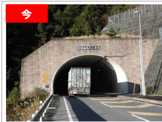
広いトンネルをスムーズに走行するトラック (H26.12月撮影)
