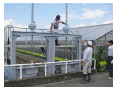
農業用施設の機能点検の様子
