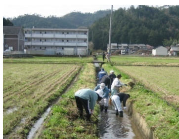
水路の泥上げの様子
