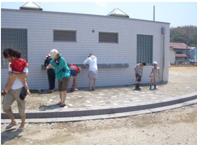
トイレ整備状況
