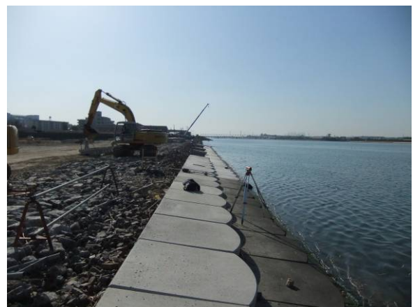
写真：階段護岸整備状況
