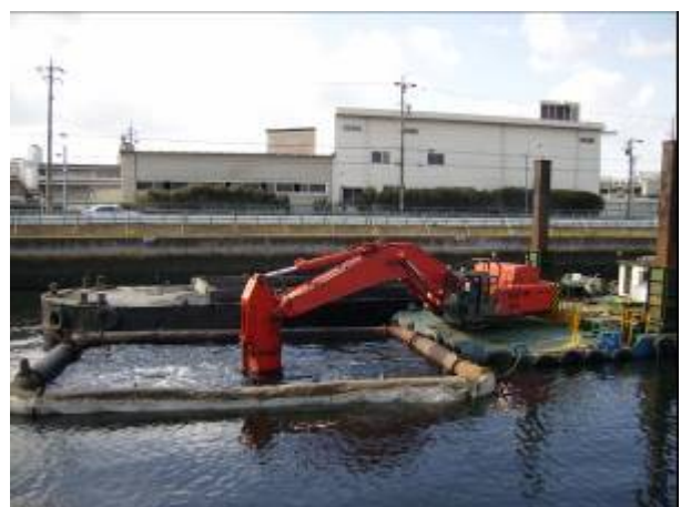
写真：浚渫の様子
