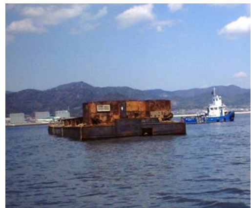
写真：埋戻し状況写真
