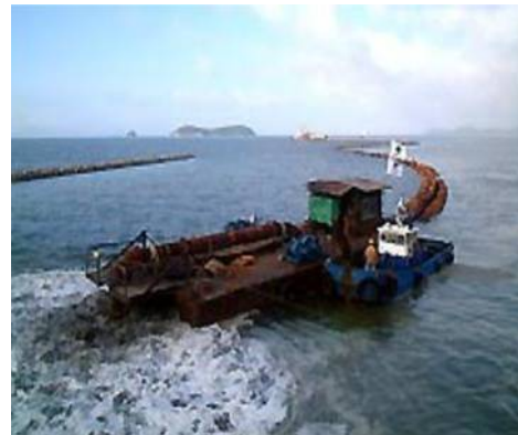
写真：覆砂実施状況
