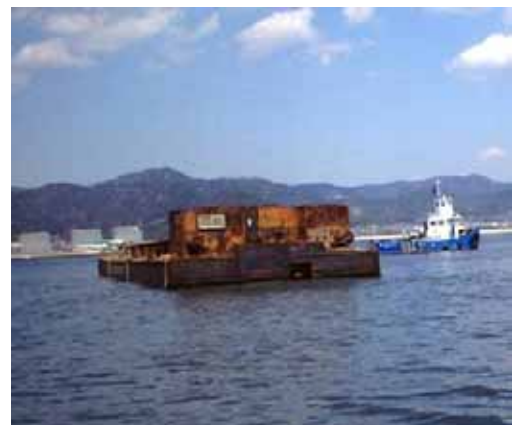
写真：埋戻し状況写真
