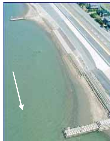
揖斐川で再生された干潟(H15施工)
