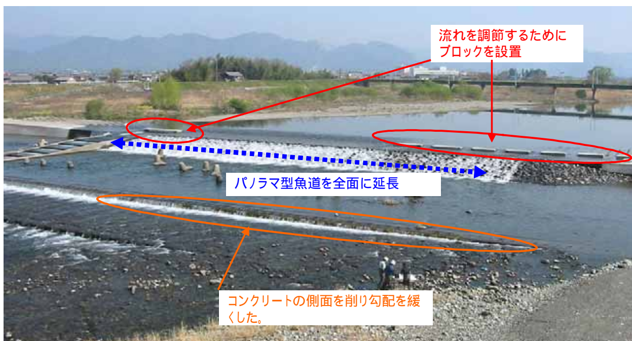
対策済み箇所の事例（根尾川第2床固）
