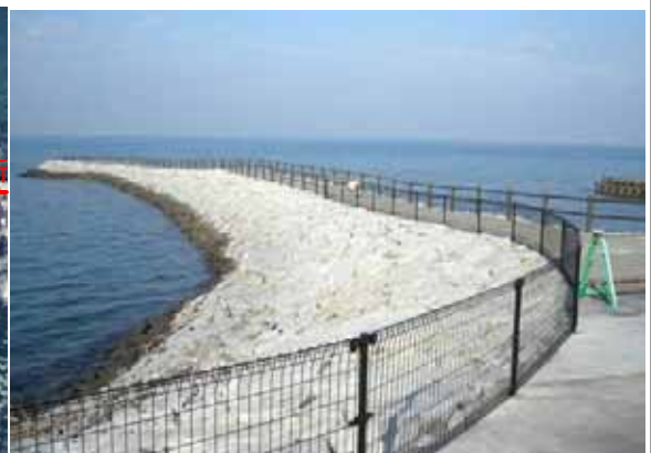
写真：平成20年度整備箇所
