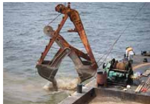
ダム堆積砂の海中投入
