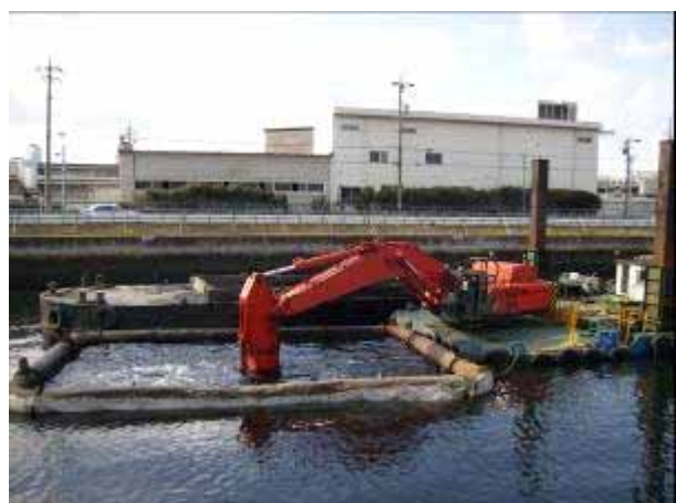
写真：浚渫の様子
