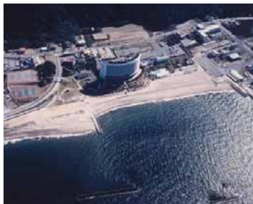
写真：平成11年状況
