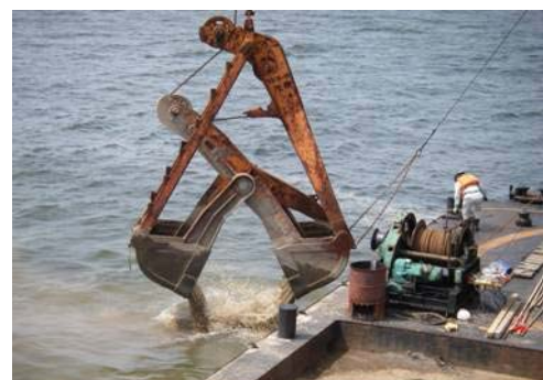
ダム堆積砂の海中投入
