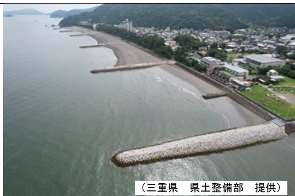
M-37 いきいき海の子浜づくり(養浜状況) 人々が利用しやすい海岸を創出するために養 浜工を実施した
