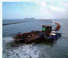
覆砂実施状況 (三河湾御津地区)
