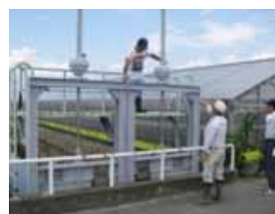
農業用施設の機能点検の様子
