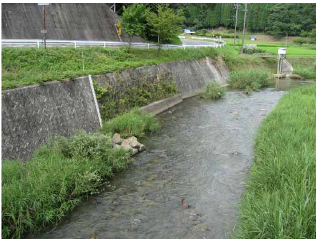
郡上橋上流側
