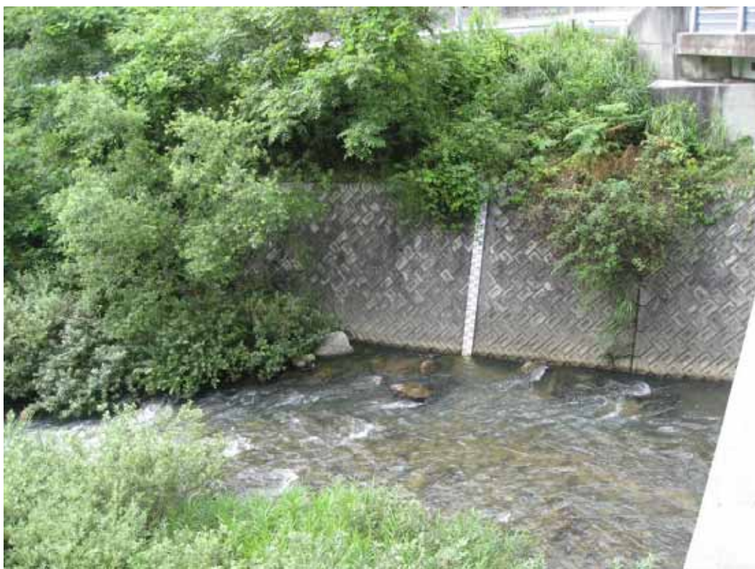
郡上橋下流側
